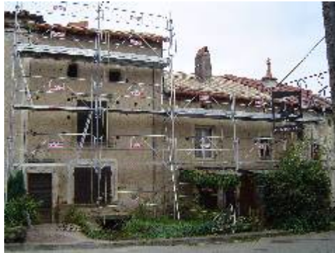
Une maison en rénovation (juste en face du Grenier à Sel)
